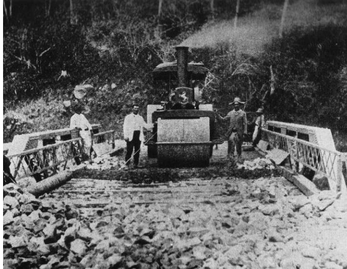
Figura 5. Carretera Central del Táchira, 1912. Fuente: Eduardo Arcila Farías, Historia de la Ingeniería en Venezuela , 2 tomos, Caracas, Colegio de Ingenieros de Venezuela, 1961.
