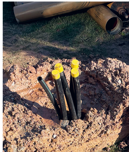
Eingebrachte Doppel-U-Rohrsonde (dA32) mit Verpressrohr
