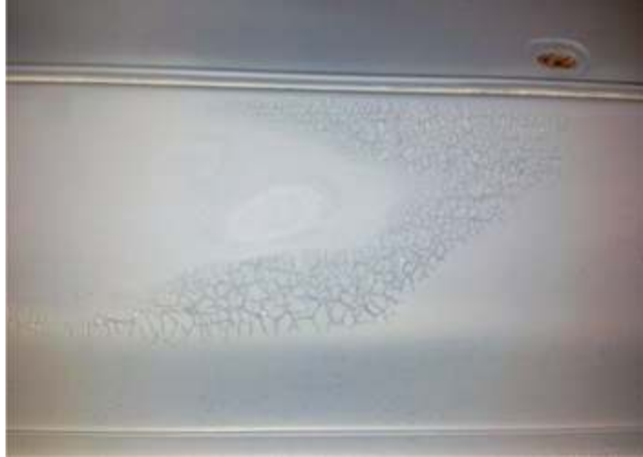
Pintura agrietada
