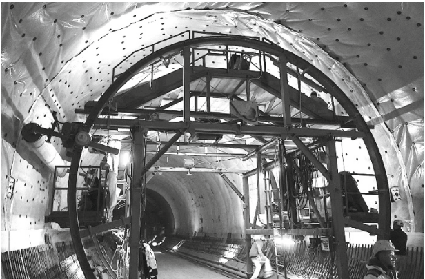
Bild 2. Bei hohen Wasserdrücken ist das neue Mehrkomponentensystem eine sichere und in der Baupraxis umsetzbare Maßnahme.
