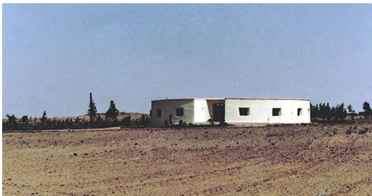
Das Rundhaus steht als erstes Gebäude. Die Bäume beginnen zu wachsen, der Boden ist schon vorbereitet
