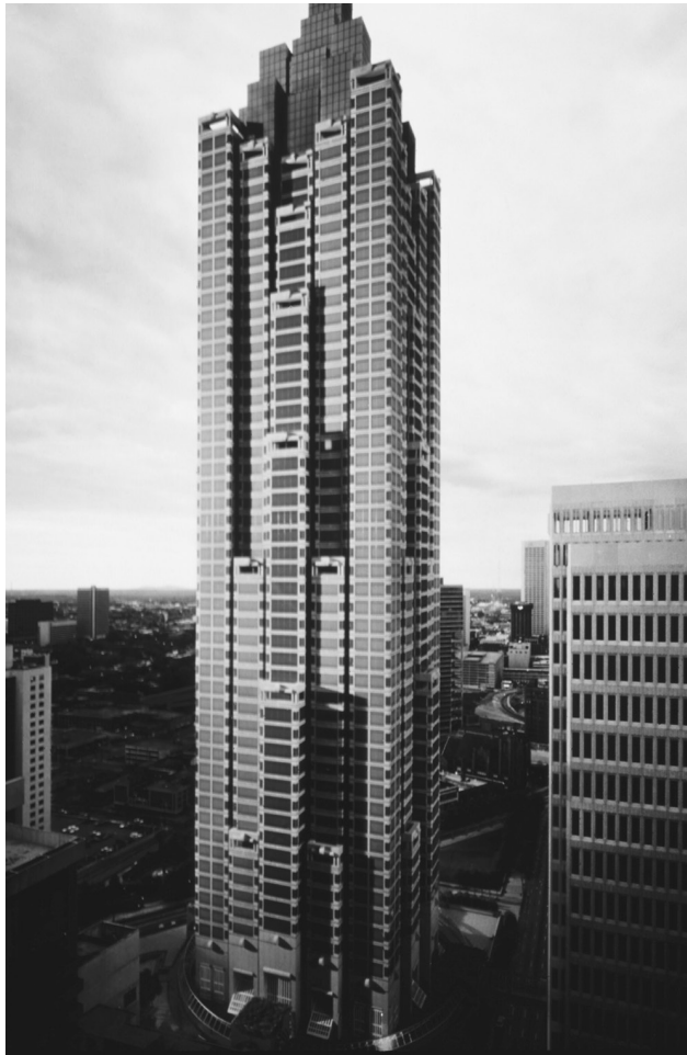
El One Peachtree Center en Atlanta, Georgia, tiene 854 pies de alto y se construyó para los Juegos Olímpicos de 1996. (Cortesía de Portland Cement Association.)
