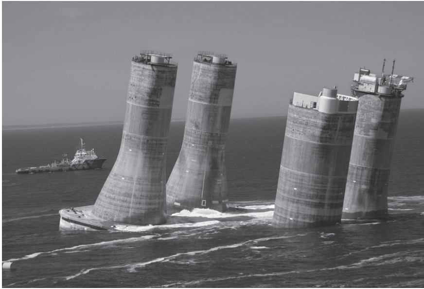
Instalación de la subestructura base por gravedad de concreto (CGBS, Concrete Gravity Base Substructure ) para la plataforma de petróleo y gas LUNA en el mar de Okhotsk, en la región de Sakhalin, Rusia. (Itar-Tass Photos/News Com.)
