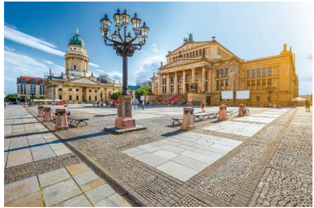
Der Gendarmenmarkt wurde nach seiner Zerstörung im Zweiten Weltkrieg zwischen 1976 und 1993 wieder aufgebaut
