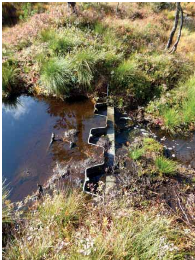
Abb. 1.6. Metallwehr zum Verschliessen eines Abflussgrabens in einem Hochmoor (Foto: Angéline Bedolla).
