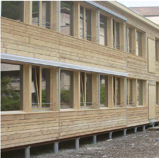
Schraubfundamente: Erdschrauben aus feuerverzinktem Stahl für bis zu dreigeschossige Gebäude
