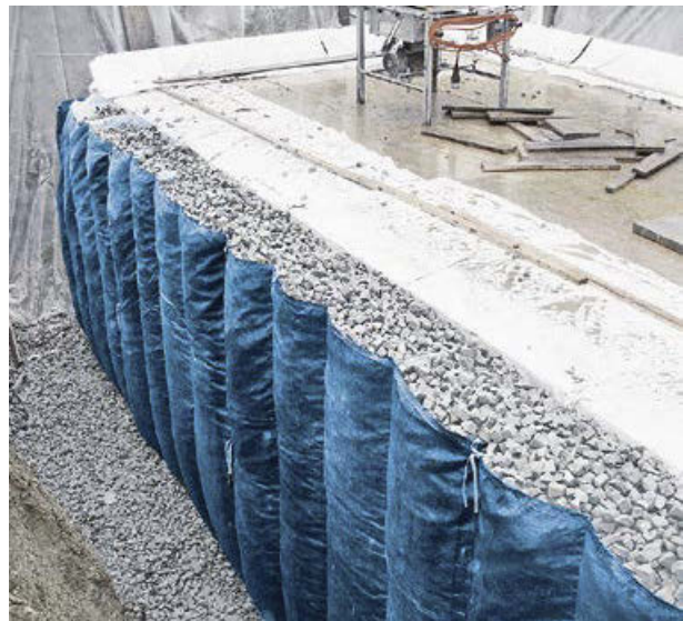
vertikale Perimeterdämmung: Schaumglasschotter in Gewebesäcken
