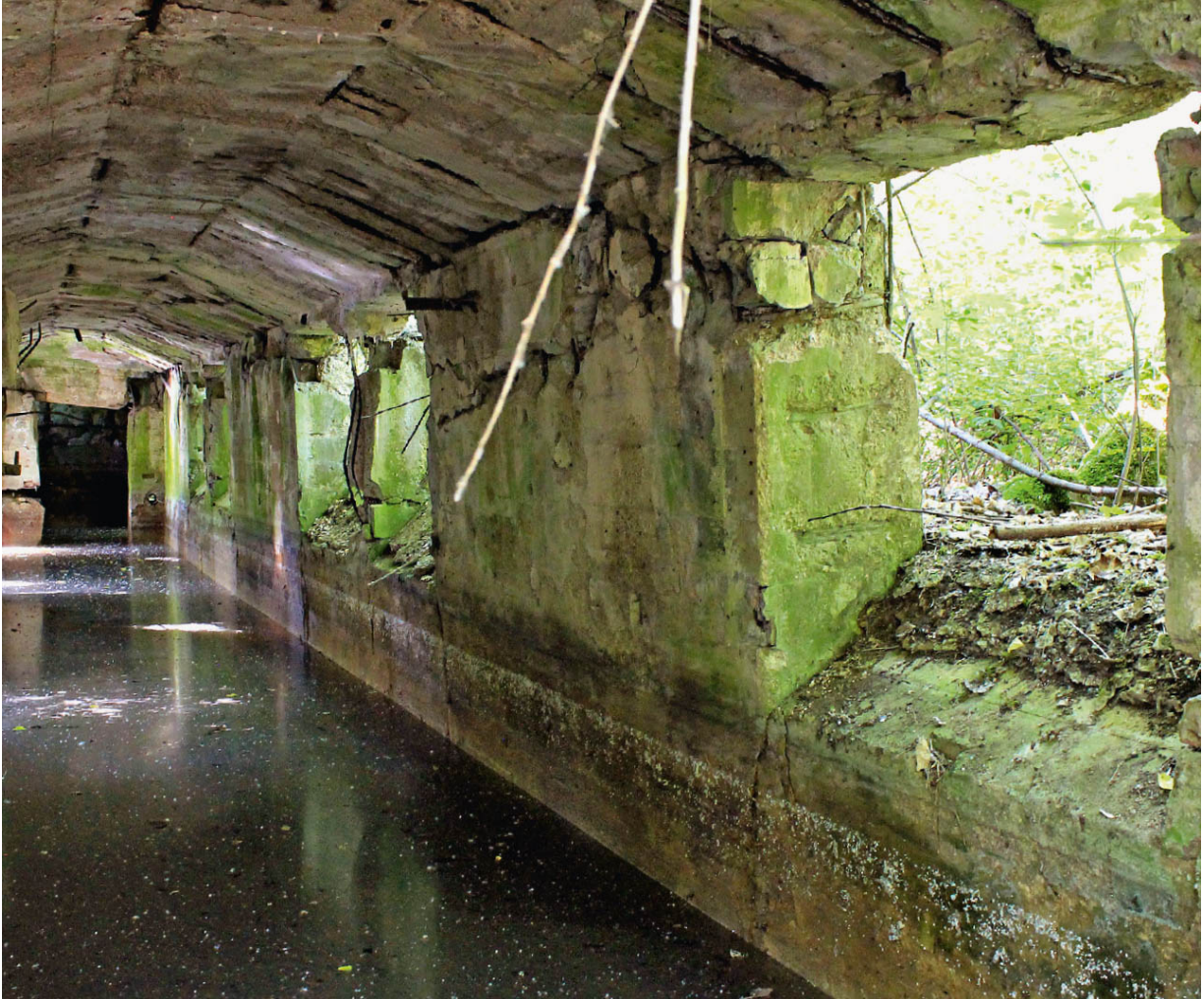
Verblüffend: die versteckten Reste der Junkerswerke in Aschersleben (Tour 8)
