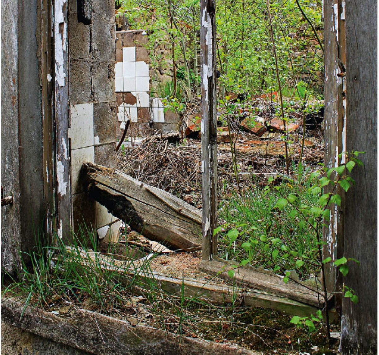
Verfallene Reste des Ferienheims Viktorshöhe bei Friedrichsbrunn ( Tour 25 )
