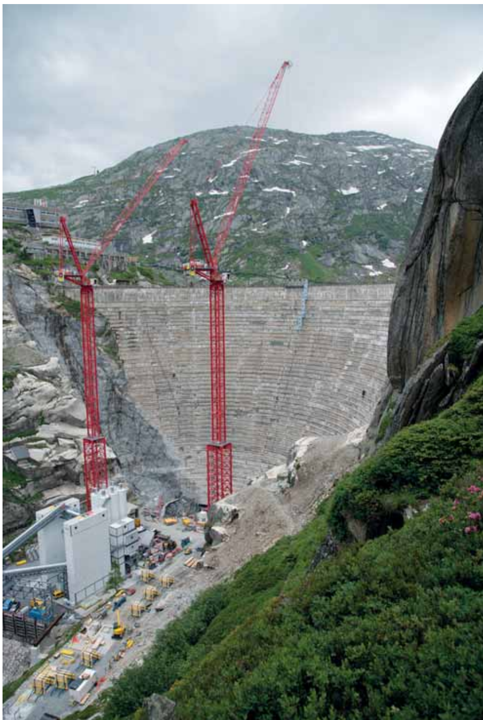
Abb. 2. Staumauer im Bau (Grimsel Juli 2021).
