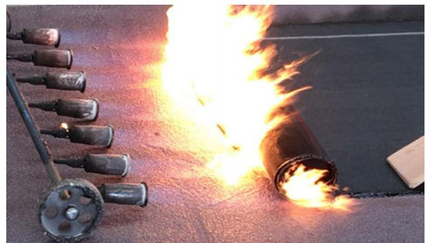
Es reicht nicht aus, nur das Bitumen der Bahn zu verflüssigen. Auch das an der Oberfläche der Versiegelung abgelagerte Paraffin muss erhitzt und damit aufgeschmolzen
