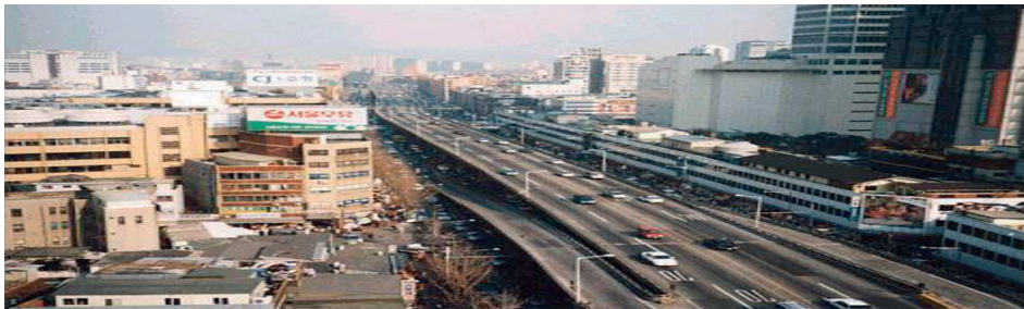
Figura iii. Autopista arteria urbana, que luego recibió una segunda vía de alta velocidad elevada de seis pistas. Fuente: goo.gl/RqLWMScontent_copy
