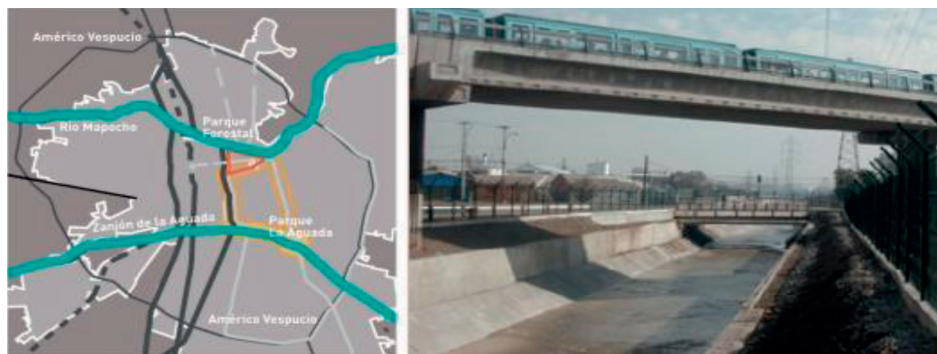
Figura i. Canal hidráulico Zanjón de la Aguada, Santiago de Chile. Fuente: https://goo.gl/rwWMra
