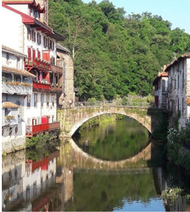
Abbildung 2: Brücke über die Nive in Saint-Jean-Pied-de-Port
