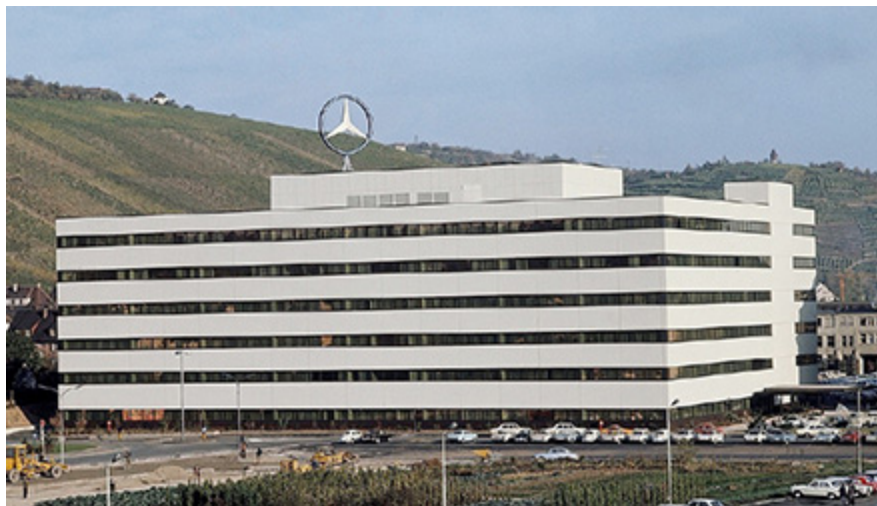
Stuttgart Werk Mettingen - Bürogebäude
