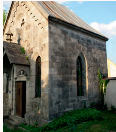
▲ An der Ölberg-Kapelle kann man bis heute noch Spuren des Beschusses sehen. Die Mauerbeschädigungen stammen von 1945. (RS)
