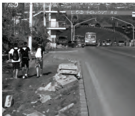
Arriba: El centro de la ciudad degradado luego de que Rio dejara de ser la Capital del País. Centro: Intensas relaciones sociales en la favela Rocinha, en Rio de Janeiro. Abajo: Sin lugar para peatones en Barra da Tijuca, Rio de Janeiro.
