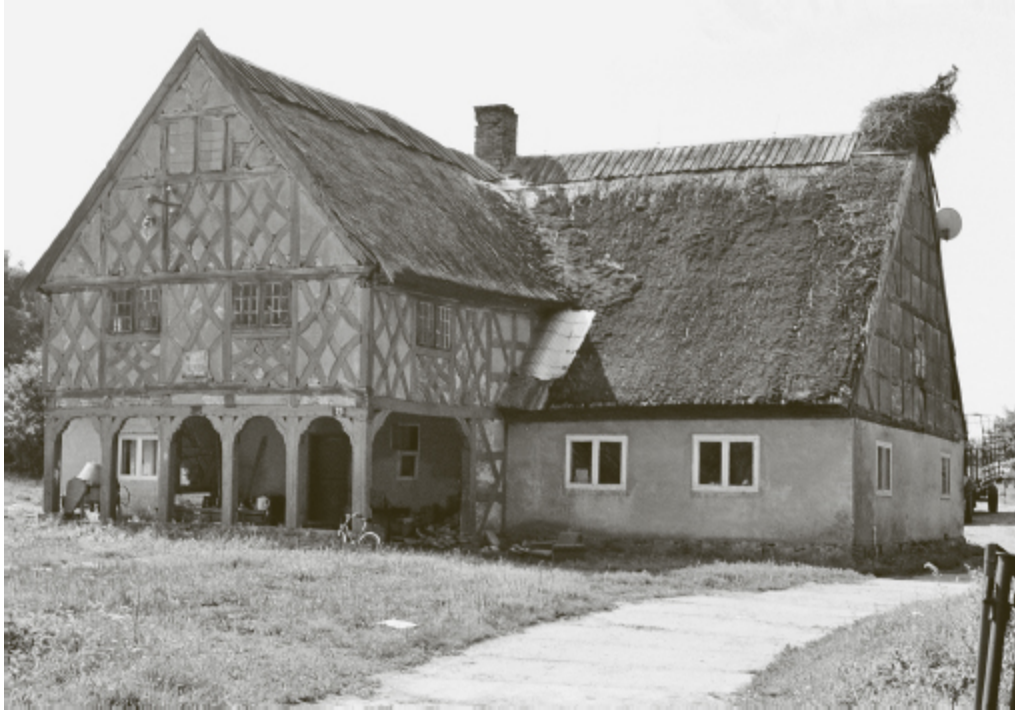
Vorlaubenhaus auf der Elbinger Höhe
