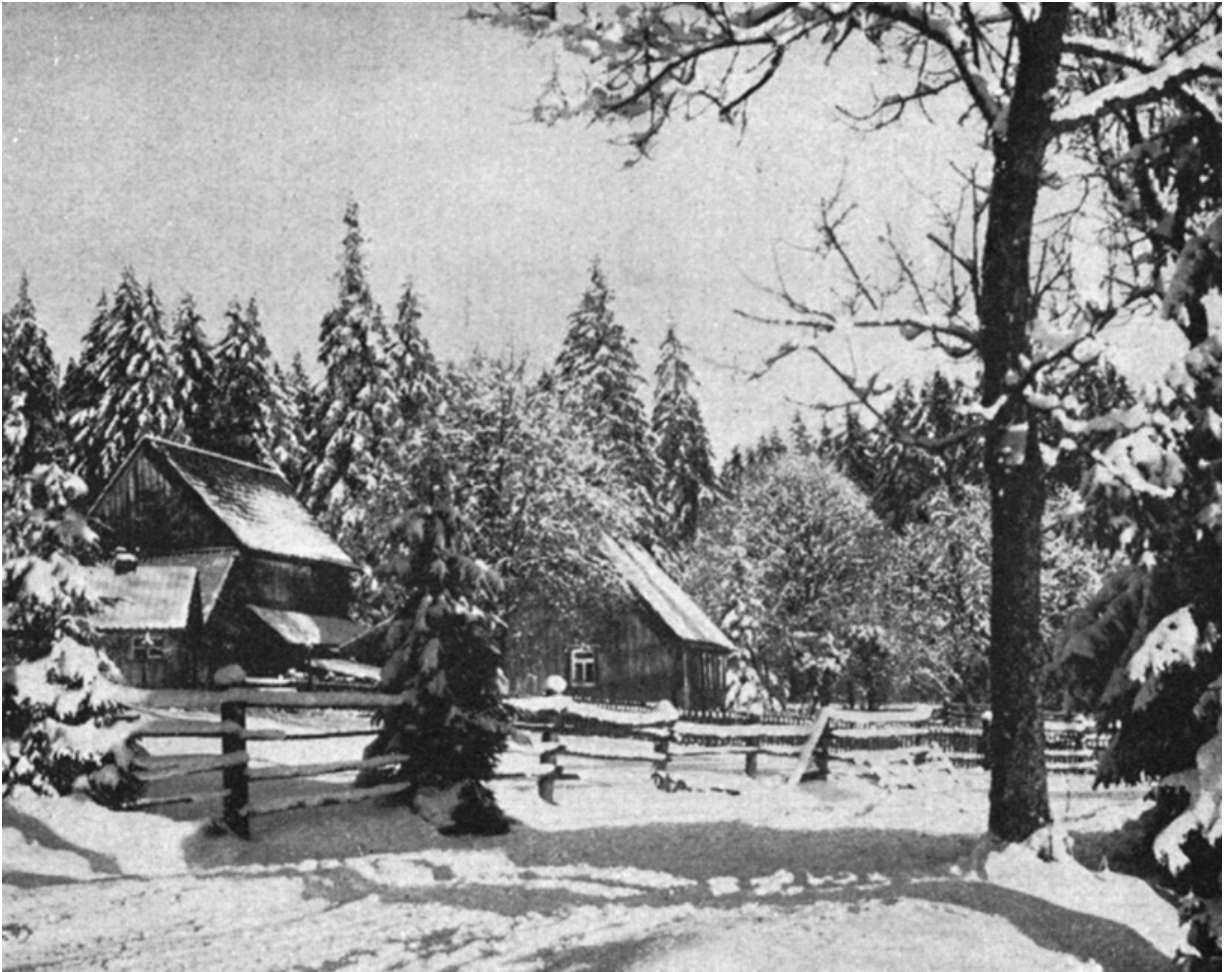
Das Zechenhaus „Obere Innerste“ bei Clausthal-Zellerfeld. Foto: Bode, Lerbach 1928.
