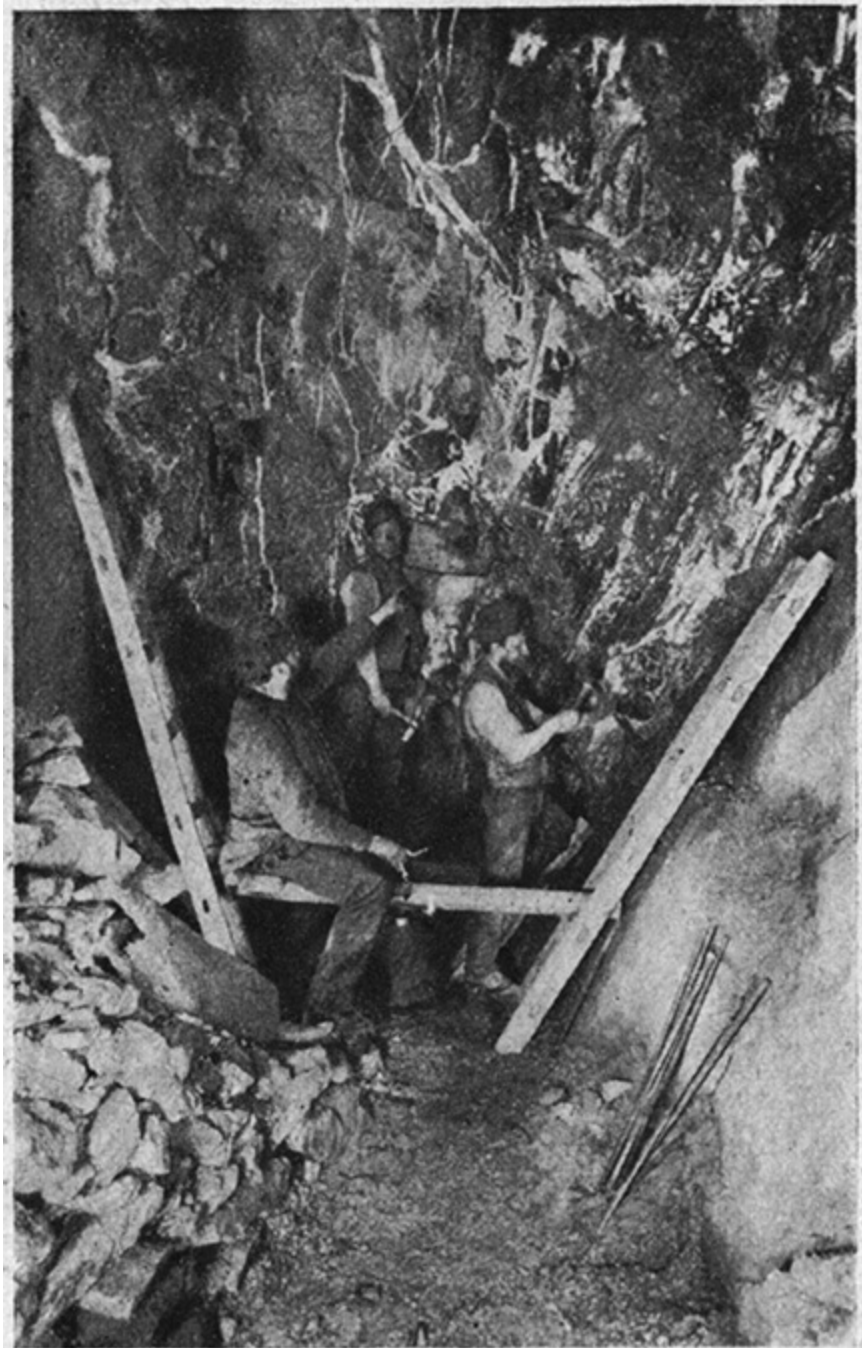
Erzstoß im Burgstädter Hauptgang (Oberharz). Die Aufnahme zeigt, wie innig die verschiedenen Bestandteile des Erzganges miteinander verwachsen sind (Kupferkies, Kupferglanz, Zinkblende, Bleiglanz, Quarz, Schiefer). Foto: Wilhelm Zirkler, Clausthal 1924.
