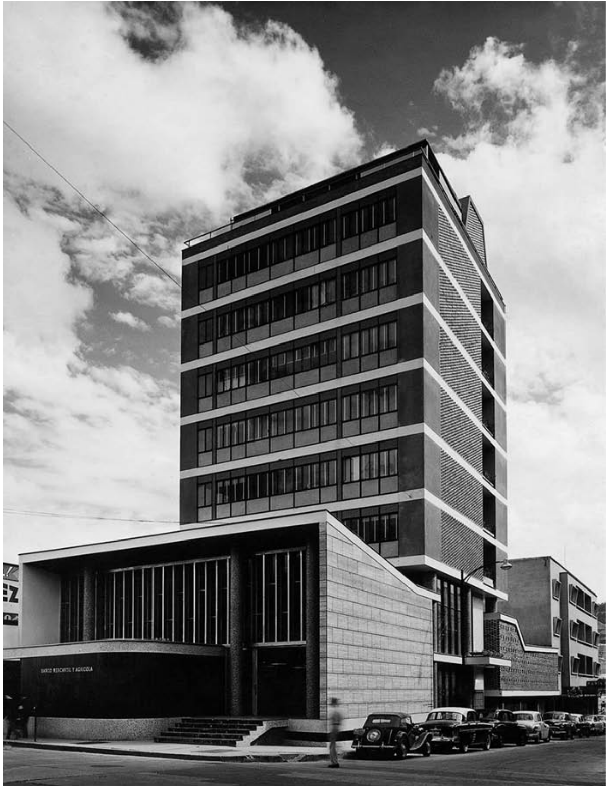
Edificio Banco Agrícola. 1955. Guillermo Palacios. © Archivo Fotografía Urbana.
