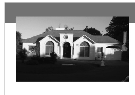
140 . Vivienda unifamiliar en barrio cerrado (Las Araucarias)
