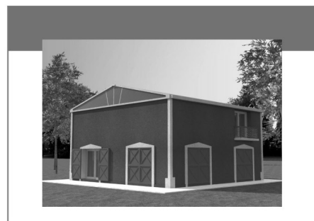
74 . Galpón - depósito con destino de loft
