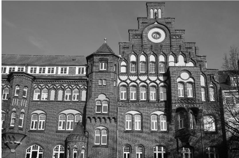
Abb. 6: Mühlenbrücke 9-11 (O. Kerwin, 1904)
