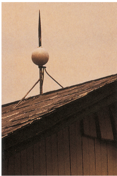
El pararrayos de este edificio está conectado a tierra para conducir los electrones desde el suelo a las nubes cargadas positivamente a fin de neutralizarlas. (© Grant Heilman.)
