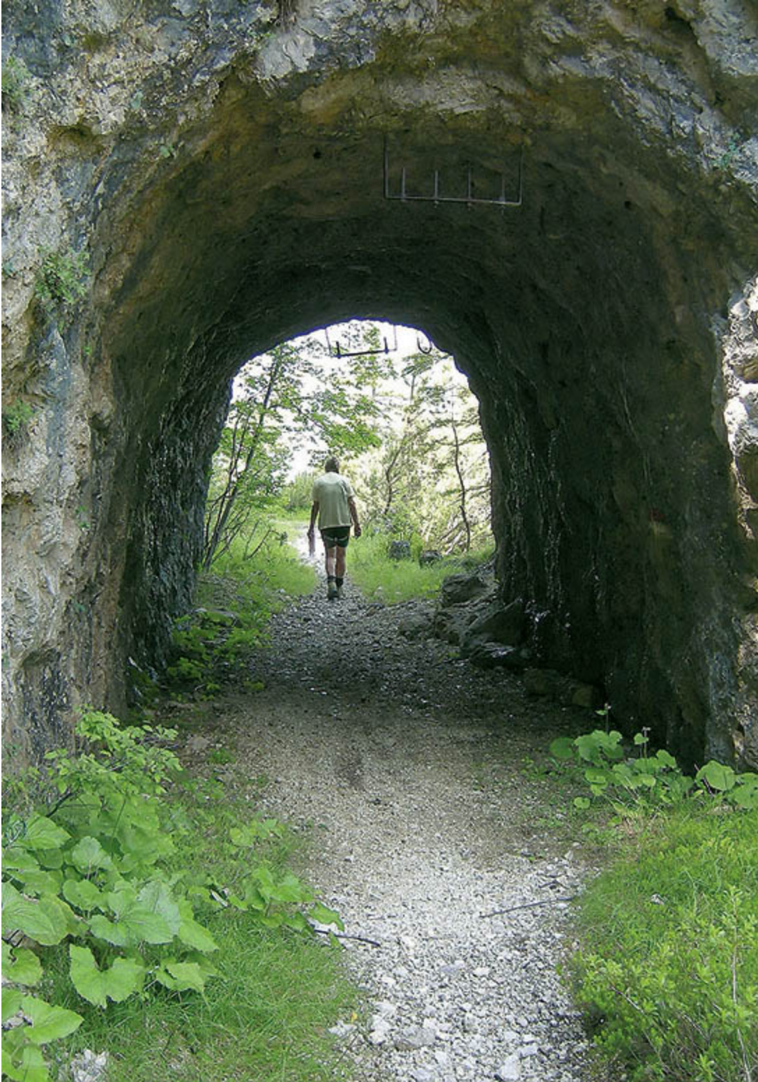
Tunnel an der ehemaligen Hauptkommandostraße TOUR 24
