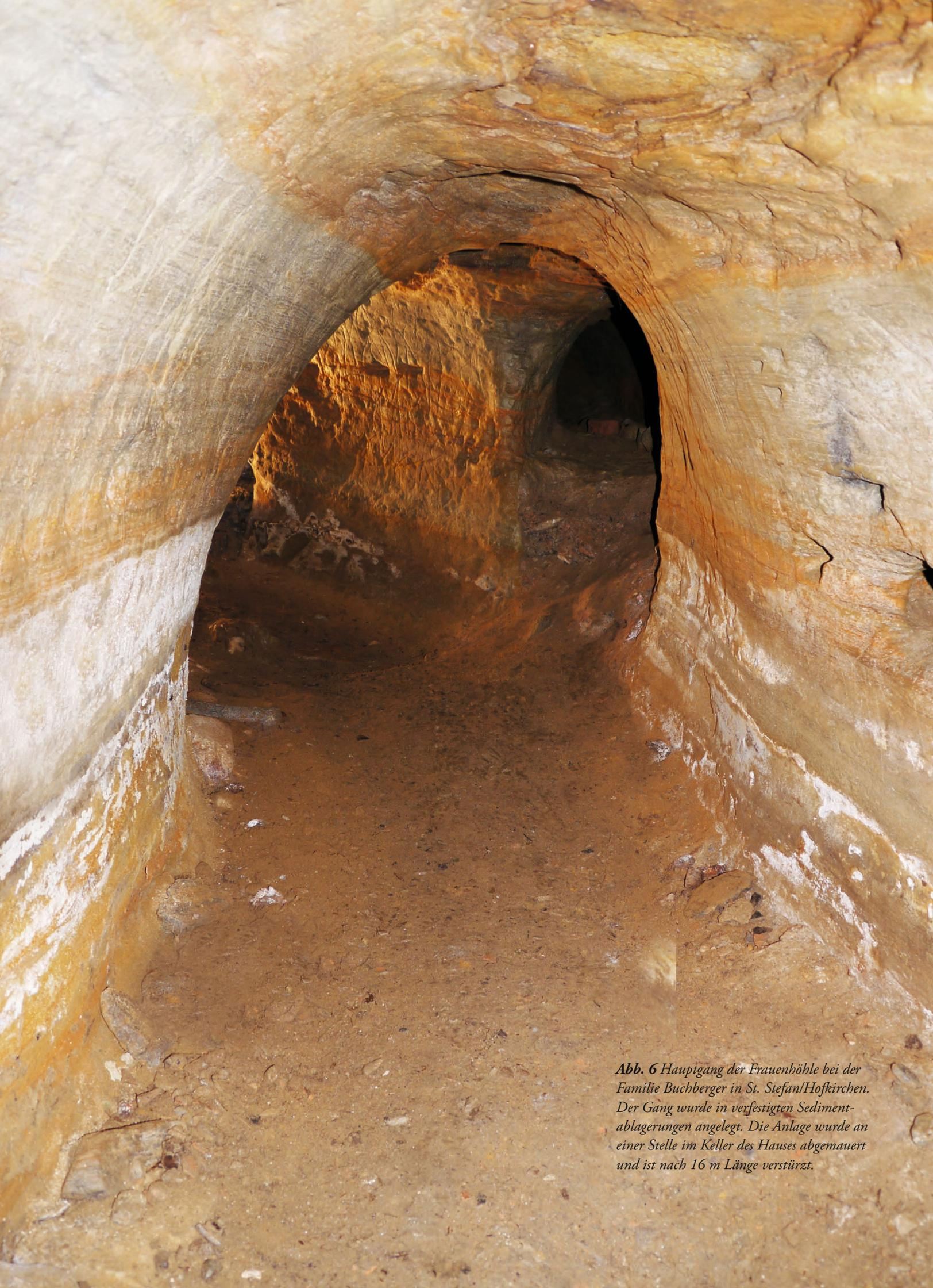
*Abb. 6 Hauptgang der Frauenhöhle bei der Familie Buchberger in St. Stefan/Hofkirchen. Der Gang wurde in verfestigten Sedimentablagerungen angelegt. Die Anlage wurde an einer Stelle im Keller des Hauses abgemauert und ist nach 16 m Länge verstürzt.*
