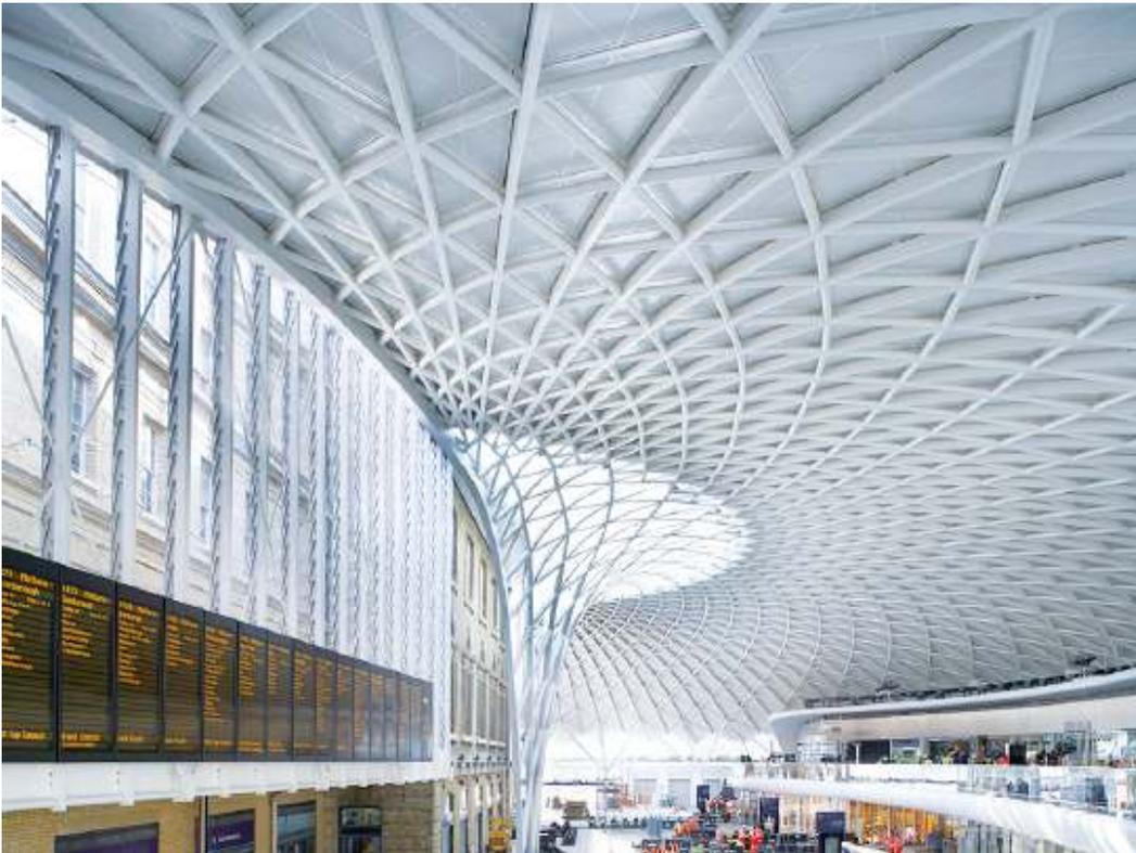
*Estructura de vigas de acero en celosía*
