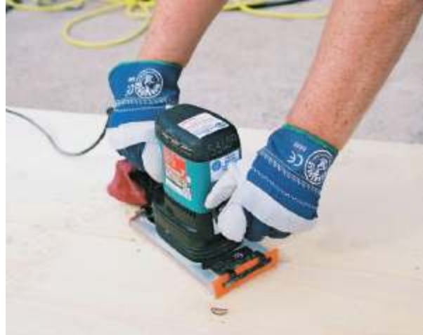
Lijado de las superficies con máquina orbital
