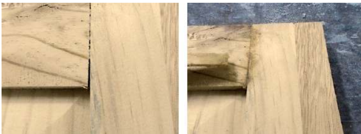
Detalle de junta en una puerta a la que se le ha aplicado masilla de pino
