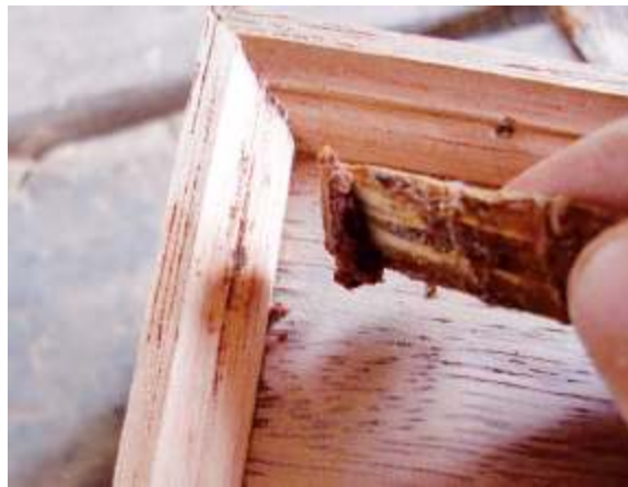
Aplicación de masilla con espátula metálica.
