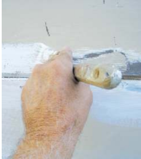
Aplicación de tapaporos en madera al exterior.
