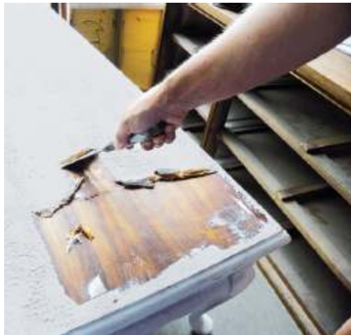
El barniz se ablanda gracias al decapante líquido.
