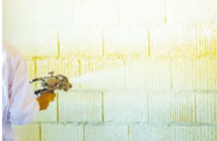
Proyectado de espuma rígida de poliuretano
