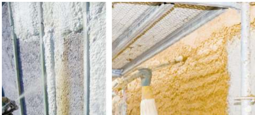
Proyectado de mortero de revoco
