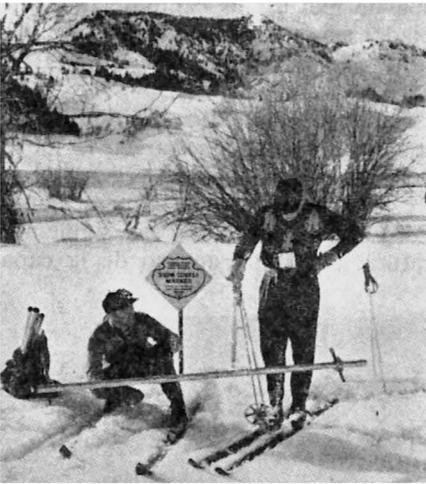
FIG. 2.3. Introducción de un tubo de muestreo en la nieve, medida de profundidad de ésta y peso del tubo y el alma de nieve para determinación del contenido de agua. (Fotografías de Bronstead. Con licencia del Soil Conservation Service, U. S. D. A.)
