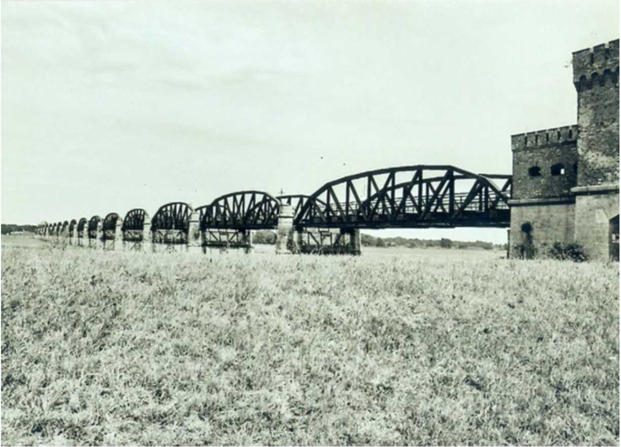
Schwedler-Träger im Zuge der Elbebrücke Dömitz 2015 (J.Braun)
