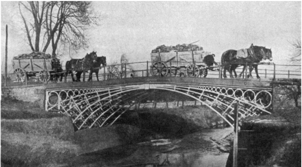
Zweite eiserne Brücke in Europa bei Laasan in Niederschlesien. Auf der Brücke Kohlefuhrwerke auf ihrem Weg vom Waldenburger Kohlerevier zur Oder (Slg. Stowarzyszenie Dolina Małej Panwi)
