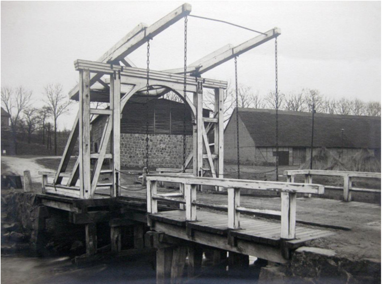
Hölzerne Waagebalkenklappbrücke über die Tollense in Klempenow. 1932 abgebrochen (Slg. Fuhrmann)
