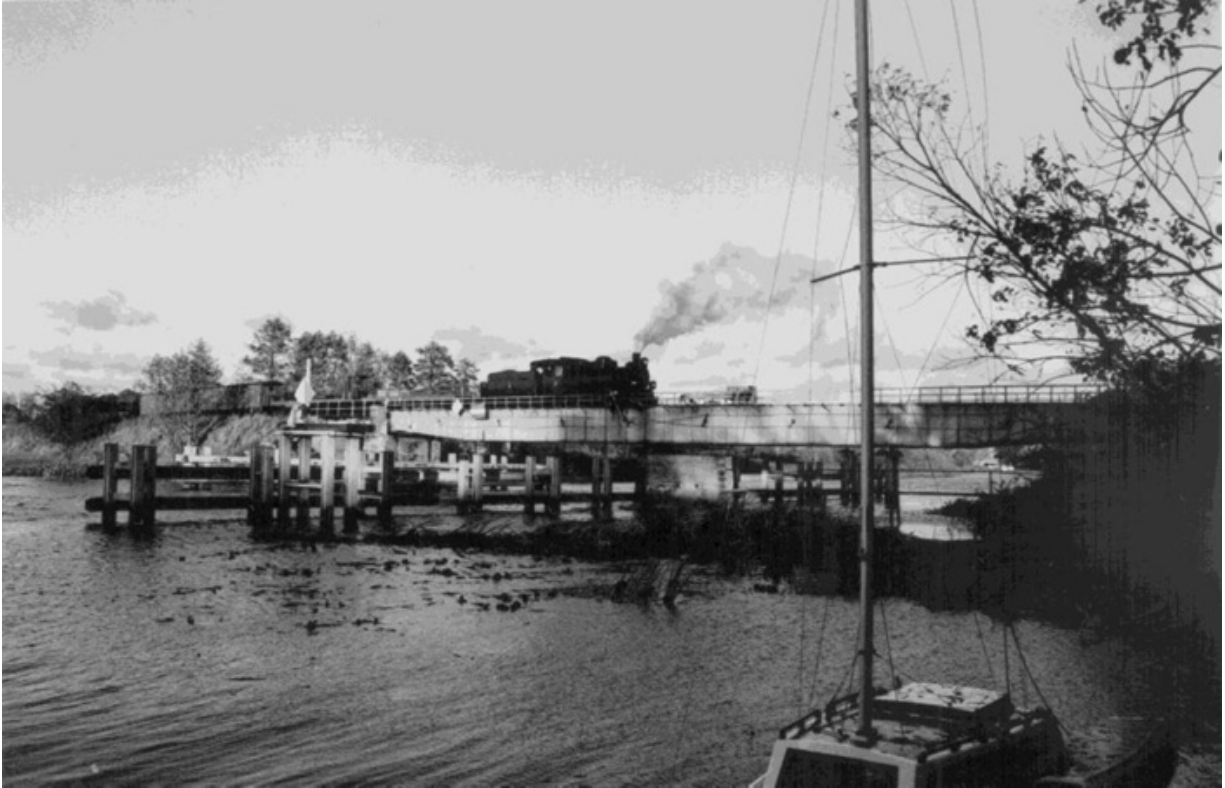
Eisenbahndrehbrücke der früheren Westpreußischen Kleinbahnen in Rybina im Weichseldelta 2010. Die Brücke wurde 1905 von der Dortmunder Union gebaut. Sie hat eine Länge von 43,40 m und wird bis heute von zwei Männern mit Muskelkraft gedreht. (J. Braun)
