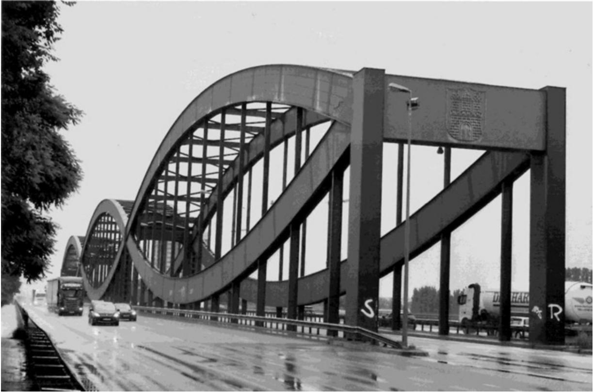
Pauli-Träger. Brücke über die Norderelbe in Hamburg 2013 (J.Braun)
