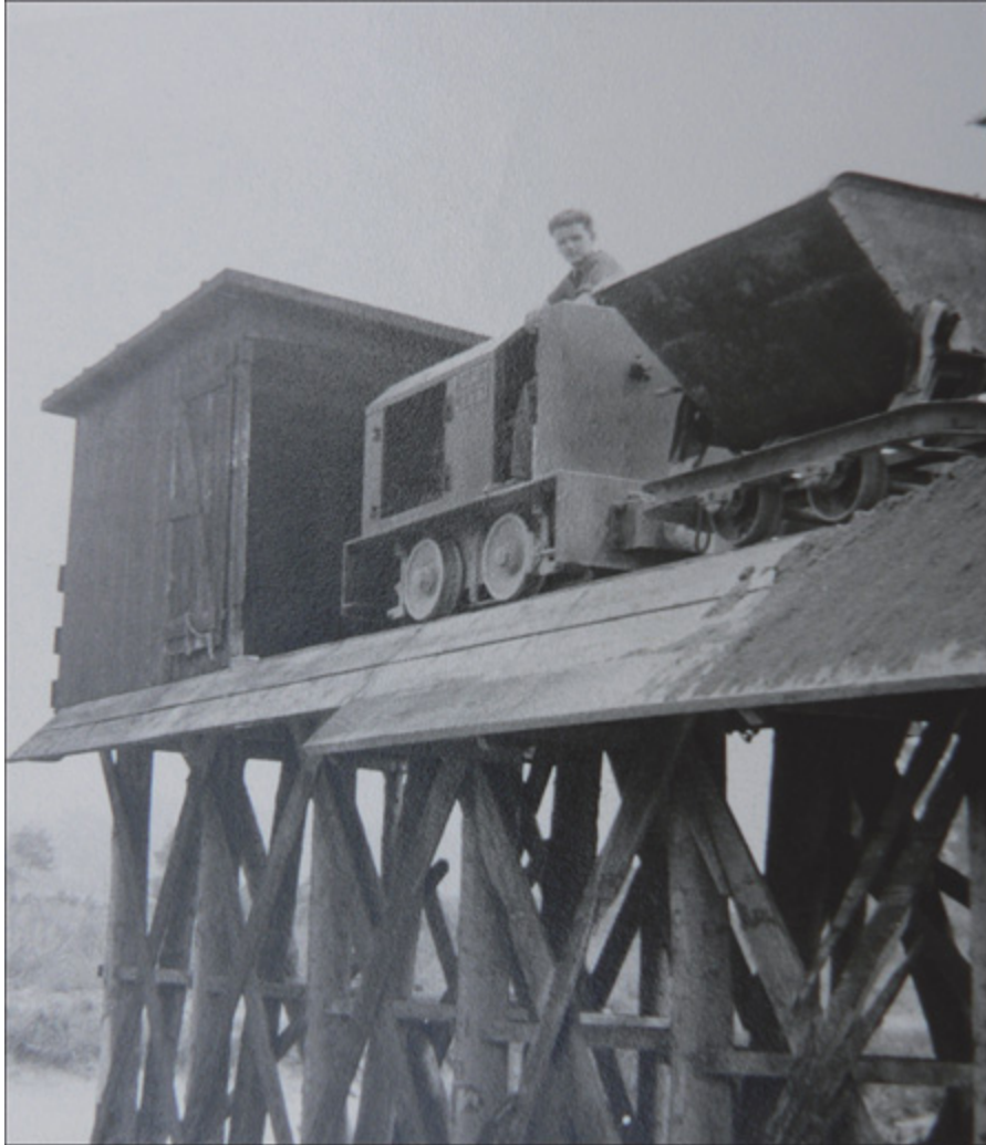
Abb. 12 Verladerampe für den Lehmabtransport hinter dem Haus Am Quellberg 38. Foto: Korf.
