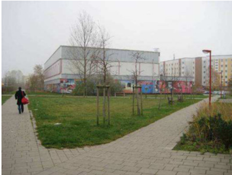
Bild 2: Die Halle am Gerüstbauerring – fortan und nunmehr seit 2009 die Heimspielhalle aller HSG-Teams
