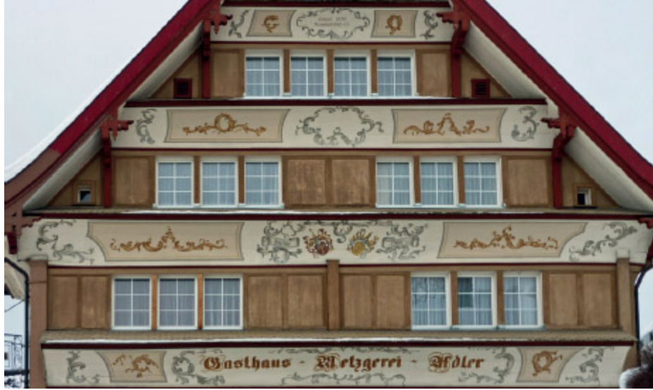
Abb. 1.1b) Fassade Restaurant Adler, Krummennau
