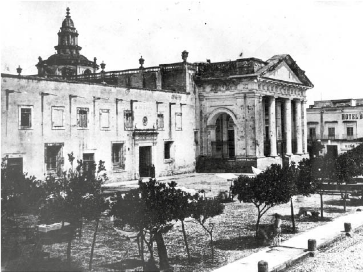
Edificio de Santo Tomás, primera sede de la Universidad de Guadalajara en 1792.
