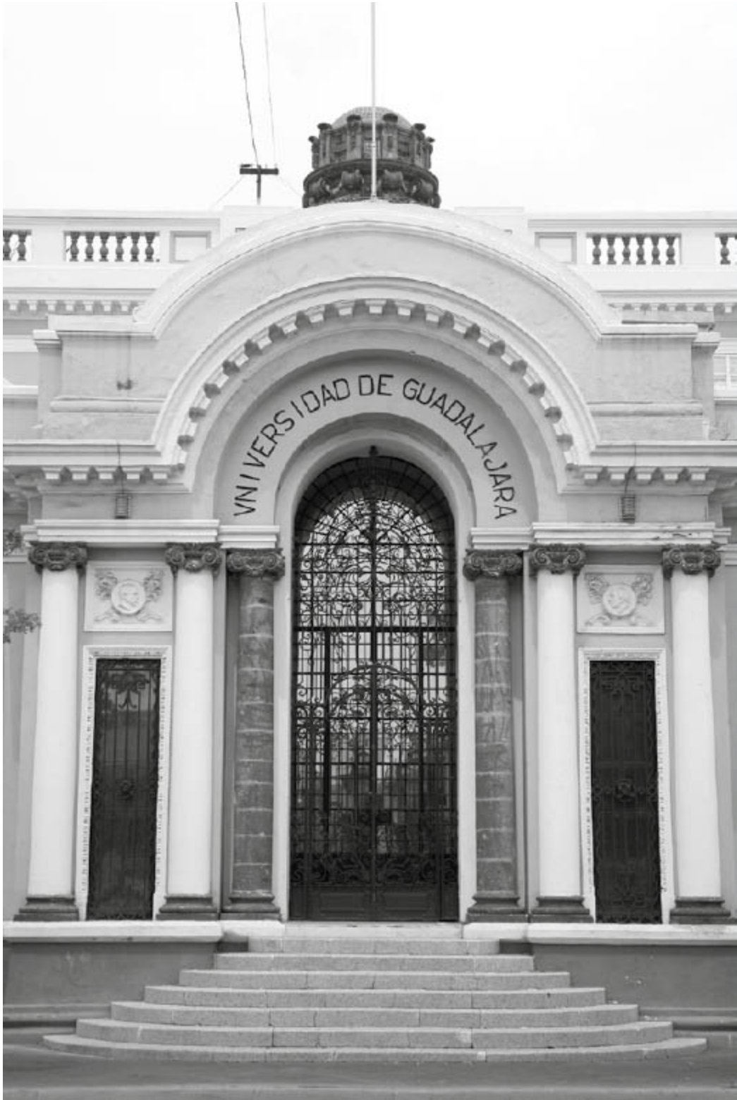
Edificio del Paraninfo, sede de la Rectoría General de 1925 al 2013.
