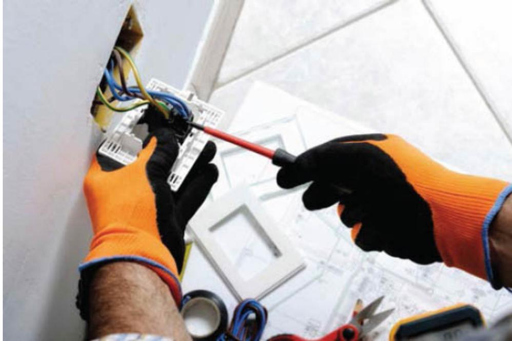
Führen Sie Arbeiten stets so durch, als stände die Anlage unter Spannung! (Foto: Shutterstock)
