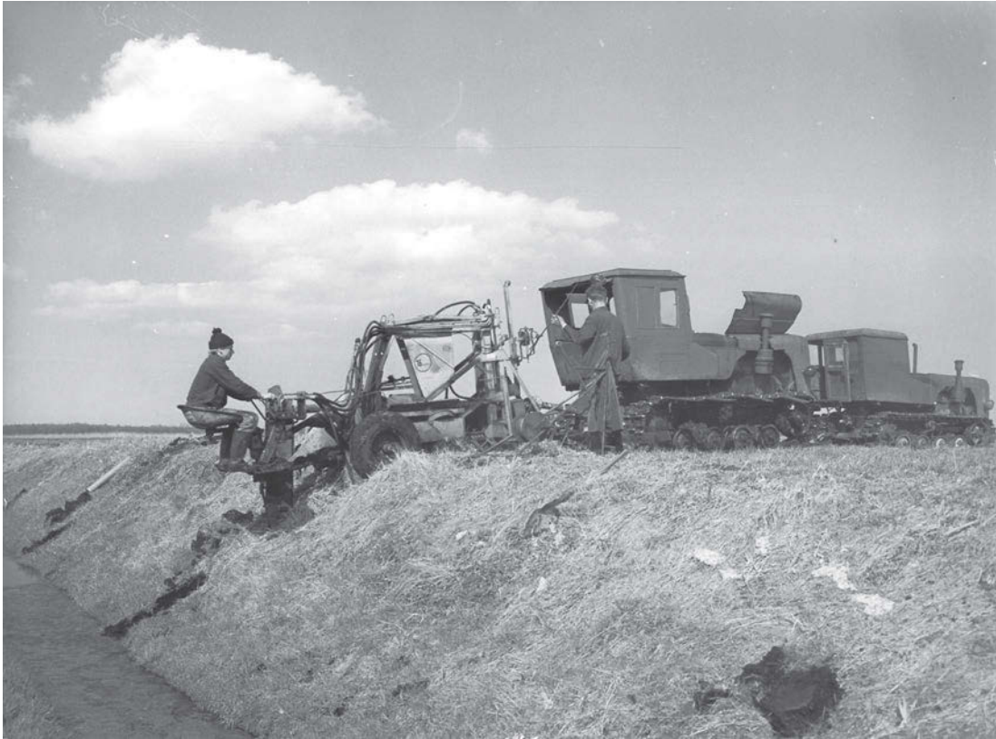
Figure 2.3: ‘Maulwurfsfräsdränung’ (mole pipe drainage) in the Friedländer Große Wiese 1971 (Zentralbild Bartocha, 26.4.71).
