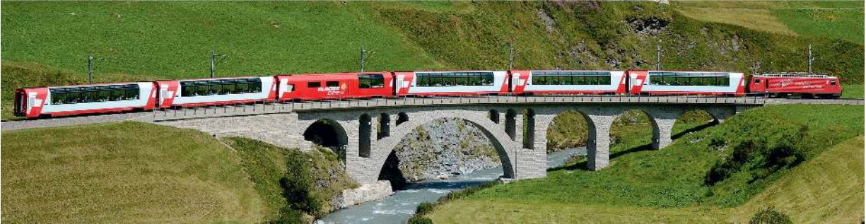
Die Richlerenbrücke führt zwischen Realp und Hospental über die Furkareuss.
