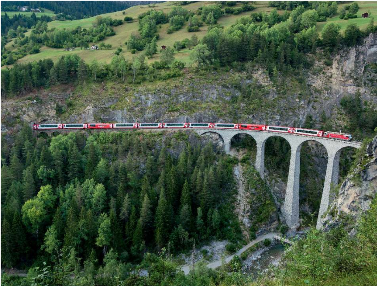
Der Glacier Express (GEX) auf dem Landwasserviadukt
