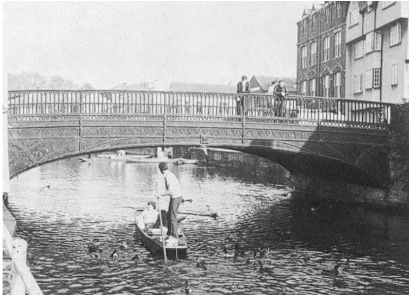
Figura 1.8 Magdalen Bridge, construido en 1823 en el lugar del antiguo puente Saxon sobre el Cam. El actual puente de fundición soportaba, hasta hace muy poco, cargas muy superiores a las previstas por los diseñadores. Por fortuna, el puente ha sido bien restaurado recientemente.
