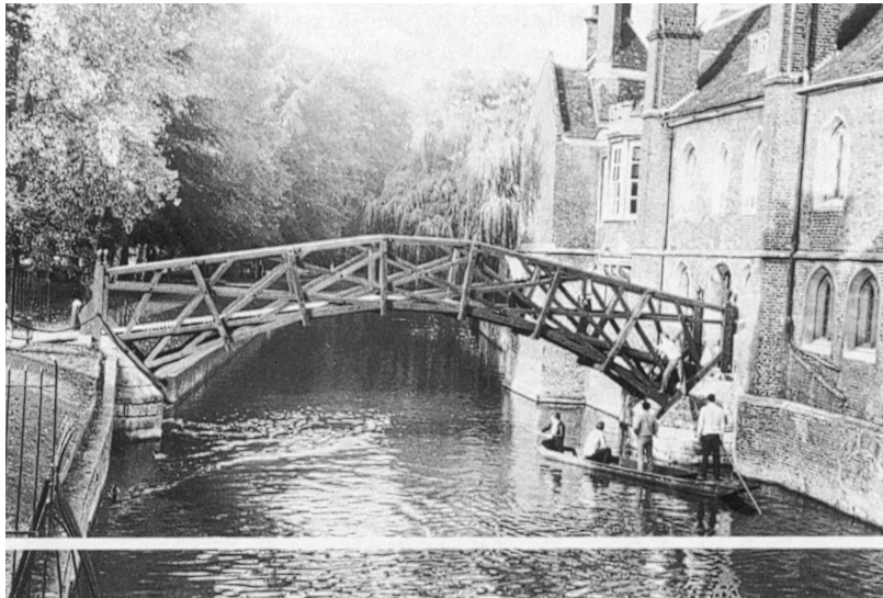
Figura 1.6 Puente de madera en el Queens' College, de Cambridge, una reconstrucción de 1902 del puente original construido en 1749 con diseño de William Etheridge.
