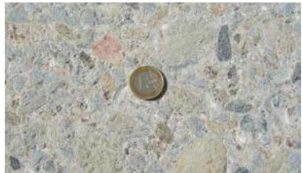
Bild 21: Geschälte Oberfläche
