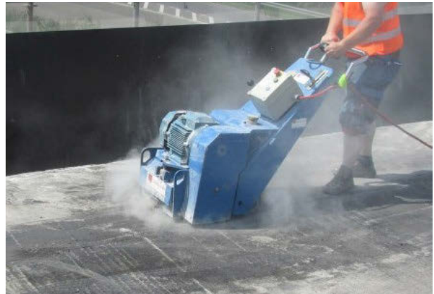
Bild 10: Lamellenfräsen
