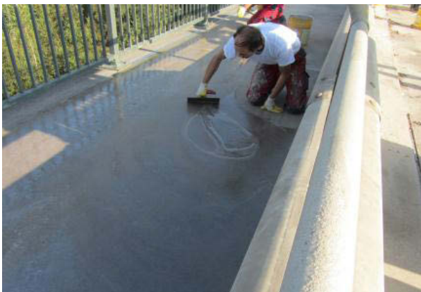
Bild 9: Kratzspachtelung nach „Fein“-Fräsen
