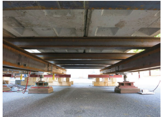
Abb. 11: Hydraulische Belastungserzeugung gegen Ballast auf Stahlträger-Konstruktion
