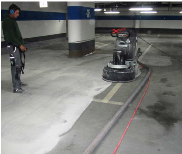
Bild I: OS 8 Parkhaus Instandsetzung Riem Arcaden in München
