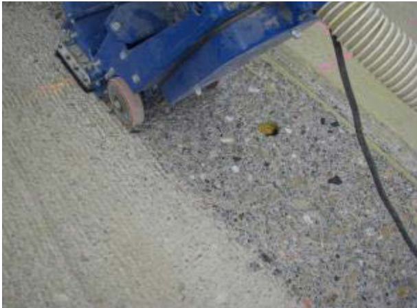
Bild 8: Kugelstrahlen nach „Fein“-Fräsen
