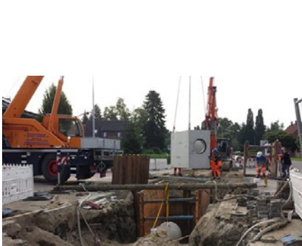
Bild 2: Setzen eines RW-Schachtes
