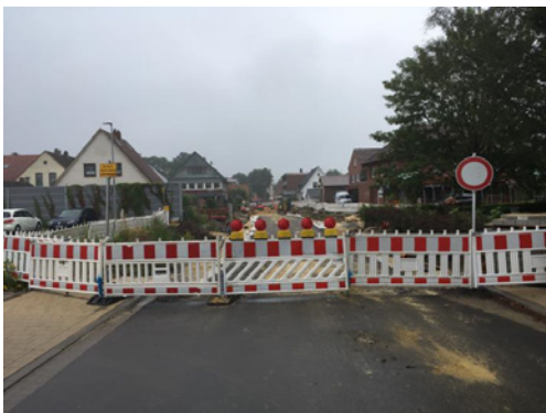
Bild 4: Blick in die Baustelle Hafenstraße, Stadt Elsfleth
