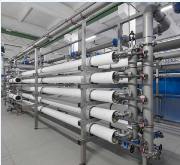
Seite 19: Dreistraßige Nanofiltration als Bestandteil einer mehrstufigen Brunnenwasseraufbereitung
