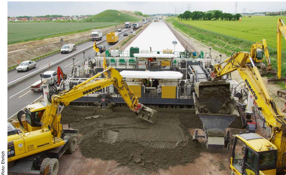
Bild 1.8: Gleitschalungsfertiger zur Herstellung einer zweischichtigen Betonfahrbahndecke mit Waschbetonoberfläche auf der BAB A14, 2008
