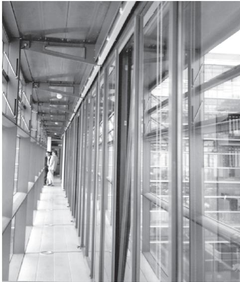
**Bild 1.14:** Begehbare doppelschalige Fassade als Beispiel für das simultane Auftreten der Wärmeübertragungsmechanismen.
