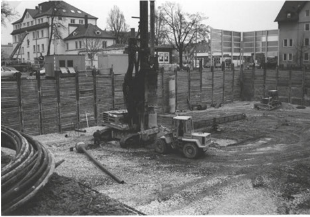
Bild 1.1: holzgefächter Trägerverbau
