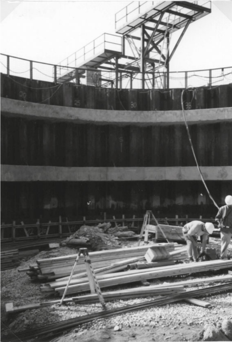
Bild 1.4: Spundwandverbau
