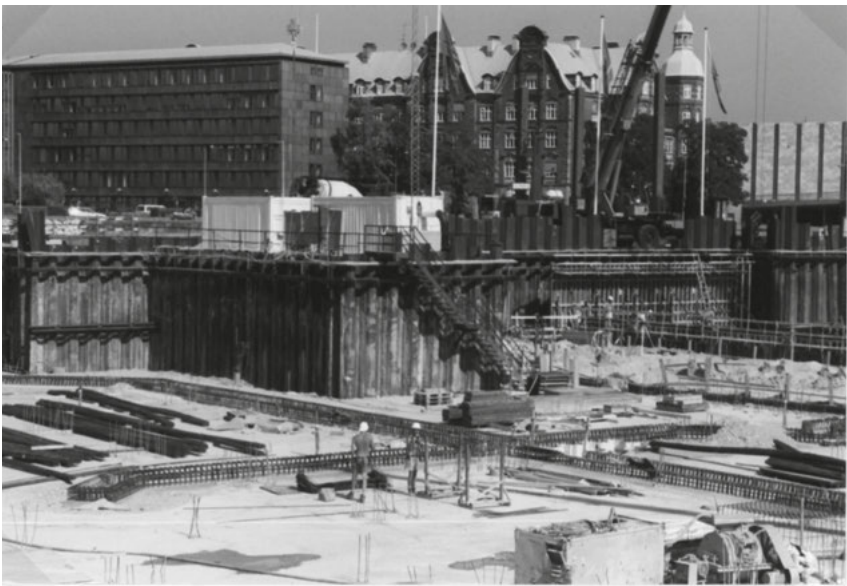
Bild 1.3: Spundwandverbau
