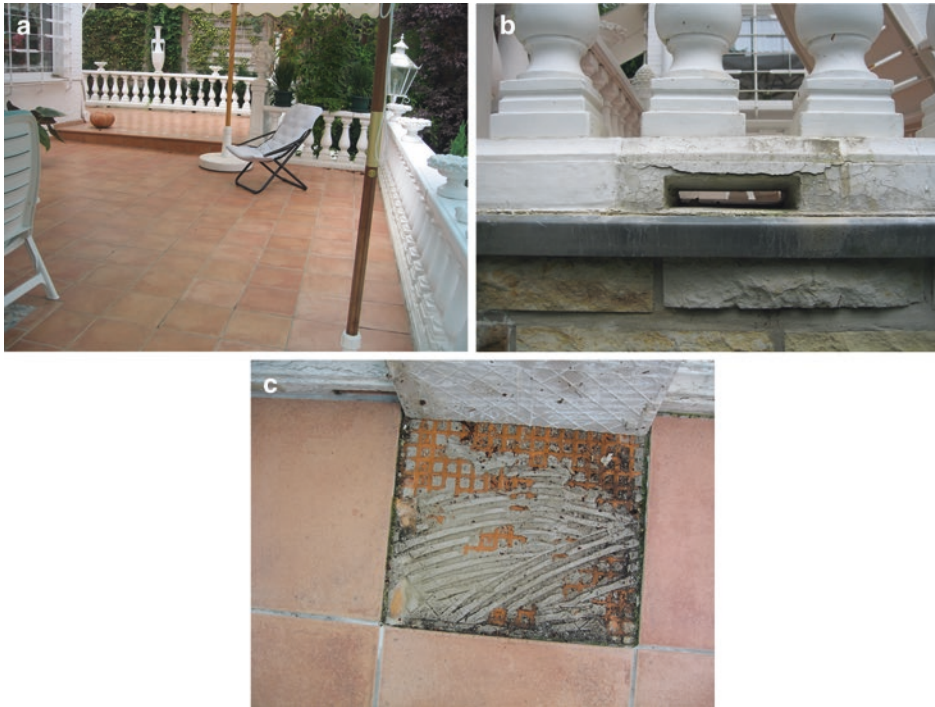
Abb. 2.5 a EG-Terrasse. b Fußbodenentwässerung. c Fliesen im Dünnbett
