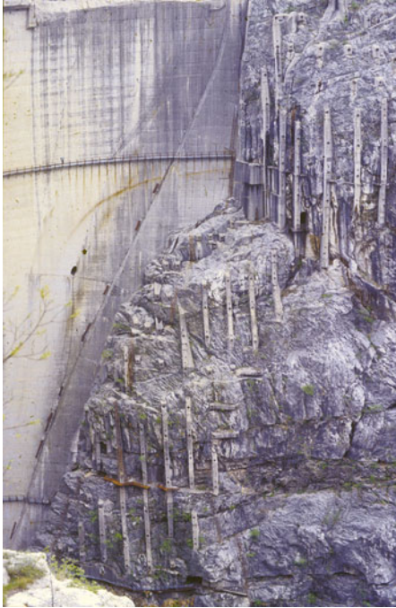
Abb. 2.1 Widerlagerverankerung der Talsperre Vajont in den italienischen Alpen.
