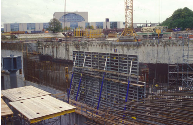
Abb. 1.2 Verankerte Baugrubenwand in Berlin.
