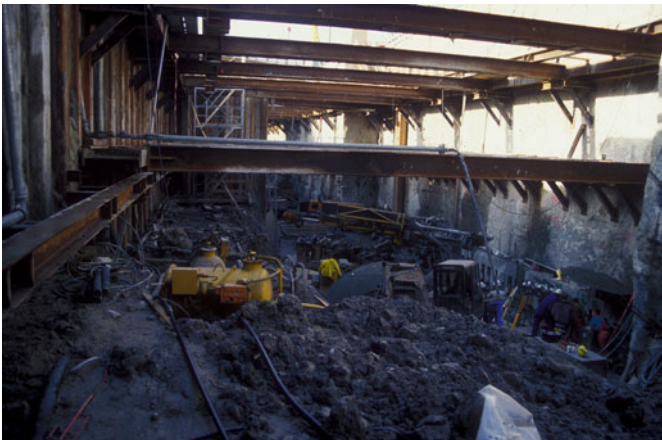
Abb. 1.1 Ausgesteifte Baugrube.
