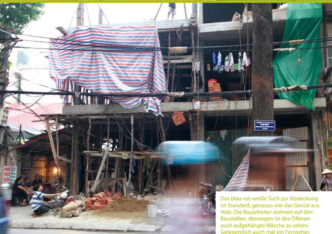
Das blau-rot-weiße Tuch zur Abdeckung ist Standard, genauso wie das Gerüst aus Holz. Die Bauarbeiter wohnen auf den Baustellen, deswegen ist des Öfteren auch aufgehängte Wäsche zu sehen. Gelegentlich auch mal ein Fernseher.
