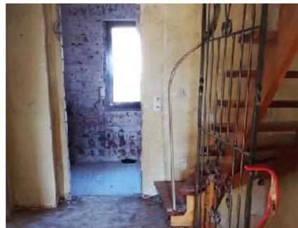
**Obergeschoss-Flur, die Erste: Vor der Sanierung wurde das gesamte Haus entkernt: Türen und Böden raus, im Bad Fliesen runter.**
