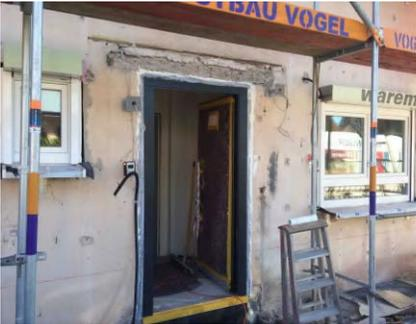
Vorher, nachher: Die alte, ungedämmte Vorhangsfassade wurde vollständig demontiert, das Beton-Vordach entfernt.
