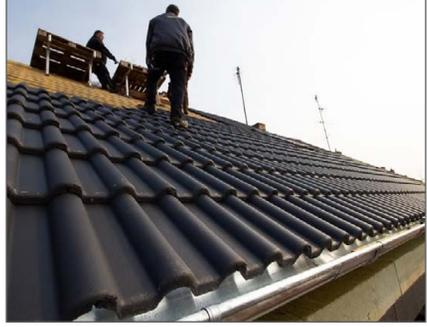
... liegt die luftdichte Ebene. Die Dacheindeckung wurde ohne weitere Verstärkung auf der Aufsparrendämmung montiert.
