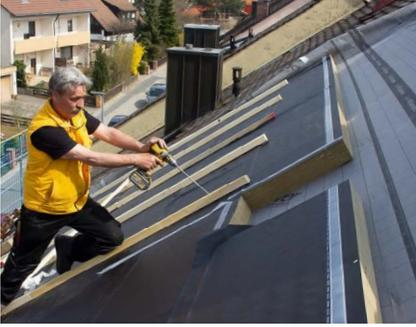
Die Dachdämmung wurde als Kombination aus Zwischensparrendämmung und Aufsparrendämmung ausgeführt. Dazwischen ...
