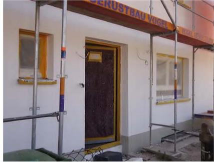
Mit dem vollflächigen Wärmedämmverbundsystem konnten alle Wärmebrücken dauerhaft beseitigt werden.
