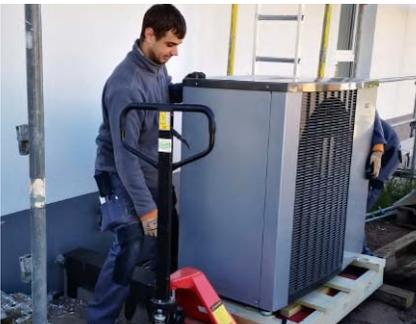
Das Außengerät der Luft-Wärmepumpe wird in Position gebracht. Hierfür wurde zuvor ein Sockel betoniert.
