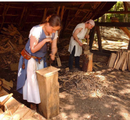
OBEN: Guédelon begeistert als kinderfreundliche Baustelle für tolle Zeitreisen ins Mittelalter. UNTEN: Die Herstellung von Dachschindeln aus Holz ist eine handwerkliche Herausforderung.
